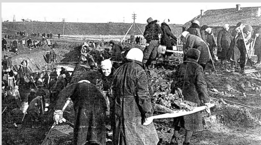
Строительство оборонительных сооружений
